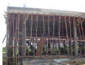
**Sparrenhout:** middelgrote ontschorste palen en stokken, traditioneel gebruikt als stutten en balken voor de constructie van tijdelijk verblijf, traditionele woningen, hutten en kamperen door binnenlandse gemeenschappen. Afhankelijk van de constructie en de afmeting in de lengte varieert de diameter tussen 7,5 en 15,0 cm.
